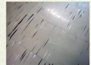
**3.4 Laminação:** nesse processo a resina é impregnada em papel ou tecido, que funciona como carga ou enchimento. As folhas impregnadas pela resina são sobrepostas e comprimidas e, através do calor, produzem o plástico laminado. Exemplo: fórmica, pisos laminados plásticos (formipiso).
