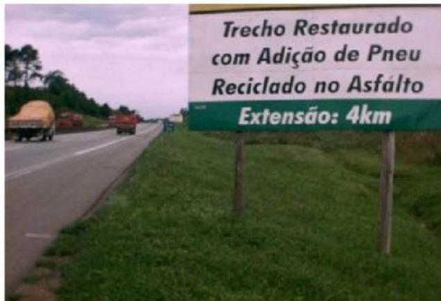
Os pneus inservíveis são cortados, triturados e adicionados em misturas asfálticas.
